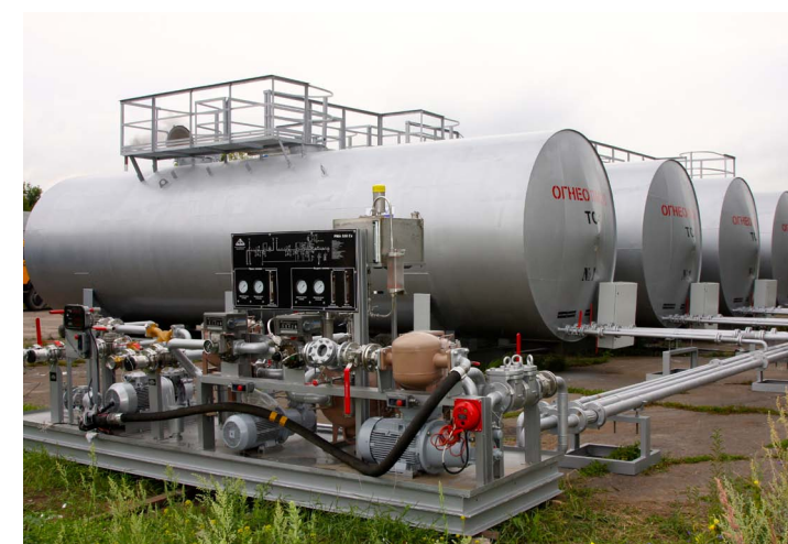
Фото 1. Типовой топливозаправочный комплекс для малых аэропортов
